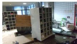
扉が飛ばされた生徒玄関
